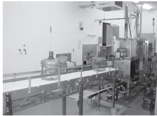
品川営業所には倉庫内に製造プラントを設置
